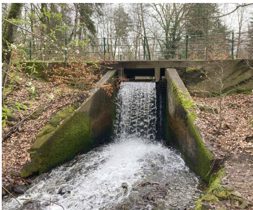
Figur 7. Stemmeværket i Milling Bæk, umiddelbart nedstrøms for Slåen Sø. Til højre ses det lovpligtige ålepas. Dette er en mulig adgangsvej til søen for D. villosus .
